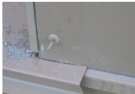
Контрафактные заклепки. Стержень отламывается до фиксации заклепки, заклепка не держит нагрузок.
