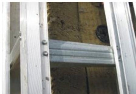
«Самоделка». Крепление оцинкованного профиля для гипсокартона к алюминиевому оцинкованным саморезами.
