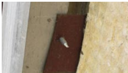
«Самоделка». Крепление алюминиевой направляющей к стальному кронштейну оцинкованным саморезом.
